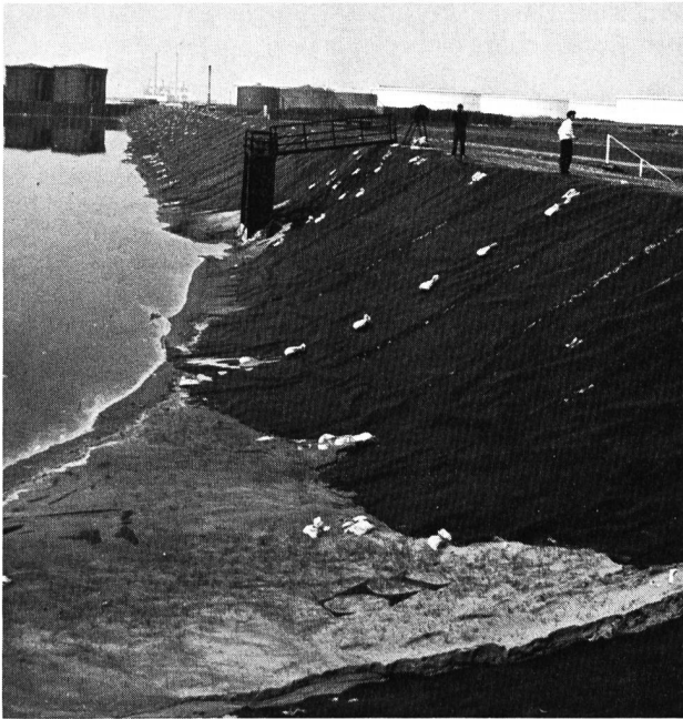
Bild 4. Blick in die bereits fertiggestellte, provisorische Deponie Papeischnabel, die die Schlammklasse 4 aufnehmen wird. (Foto B. Zarn)
