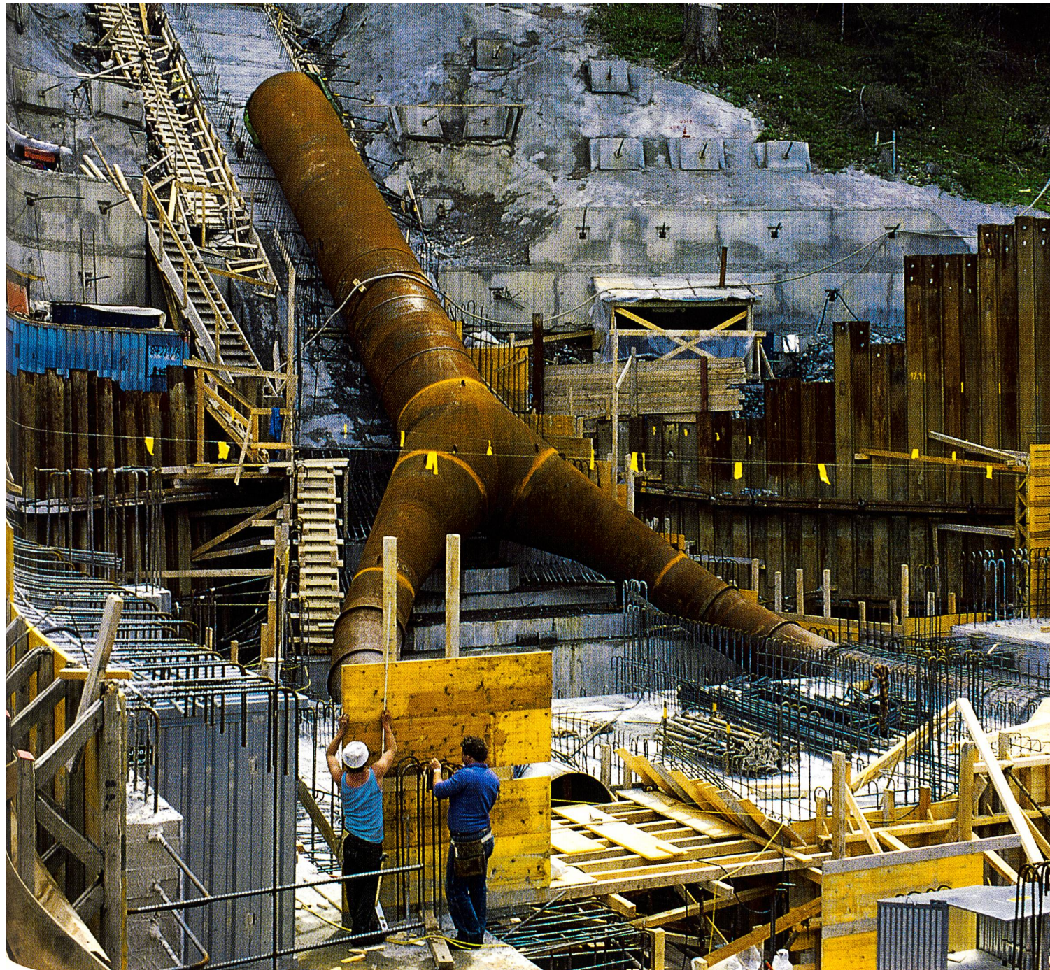
Druckleitung, Hosenrohr und Verteilleitung bei der Zentrale Tiefencastel der Albula-Landwasser Kraftwerke AG. Bauzustand: Sommer 1986. Foto: Elektrowatt AG
