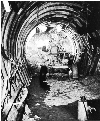
Bild 2. Vom 8600 m langen Druckstollen sind rund 7300 m mit Tunnelbohrmaschinen aufgeföhren worden. Das Bild zeigt eine konventionelle Vortriebsstrecke. Bauzustand Sommer 1986.
