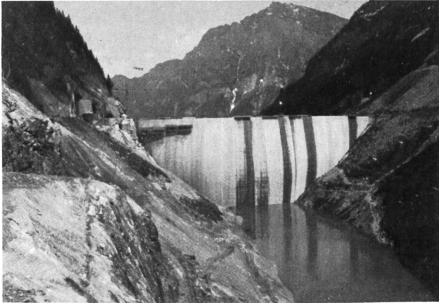
Barrage de Gigerwald, Suisse
