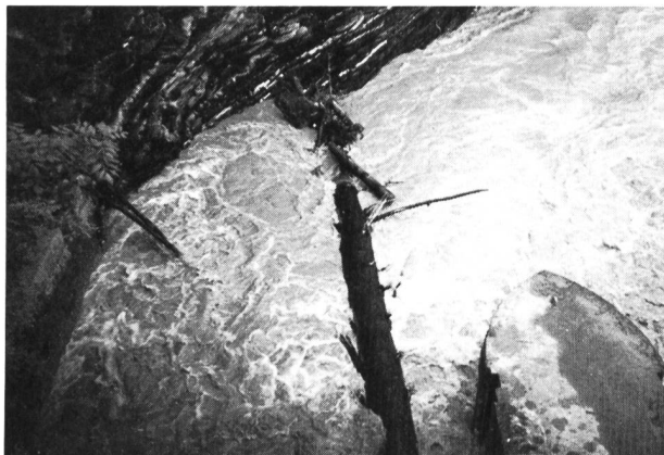
Bild 2. Blick vom Wehr des Kraftwerkes Lünen flussabwärts. Die in der Durchlassöffnung verkeilte Tanne war etwa 20 m lang, der Stamm hatte 70 cm Durchmesser (Juli 1987).
