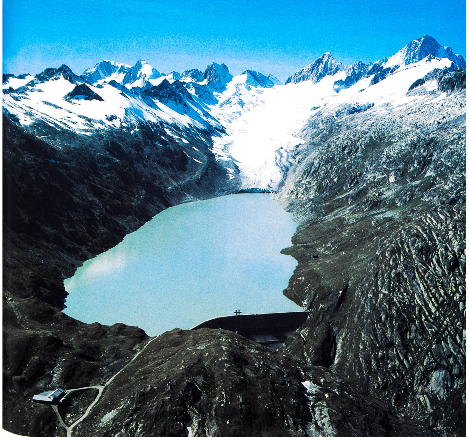
Stausee Oberaar der Kraftwerke Oberhasli AG: Umrüstung und Erweiterung der Messeinrichtungen der Staumauer Oberaar in den Jahren 1981–1985 (siehe Beitrag von Georges Collet auf Seite 127 f.)
