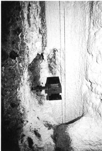
Bild 4. Staumauer Spitallamm. Unverrohrte, versinterte Bohrung mit Loteinrichtungen.
