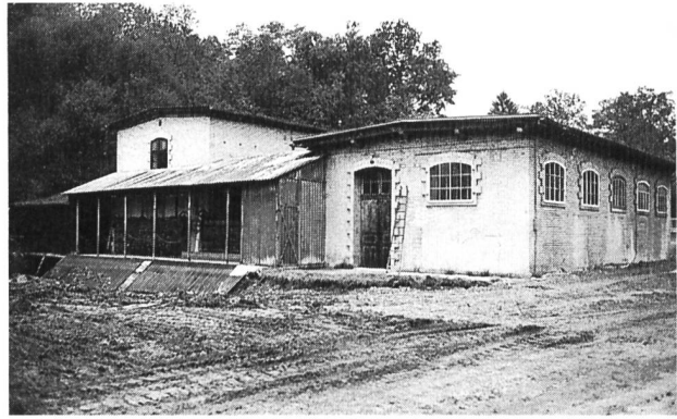
Bild 1. Alte Wasserkraftanlage vor der Erneuerung (linker Gebäudeteil 1888, rechts Erweiterung 1905).
