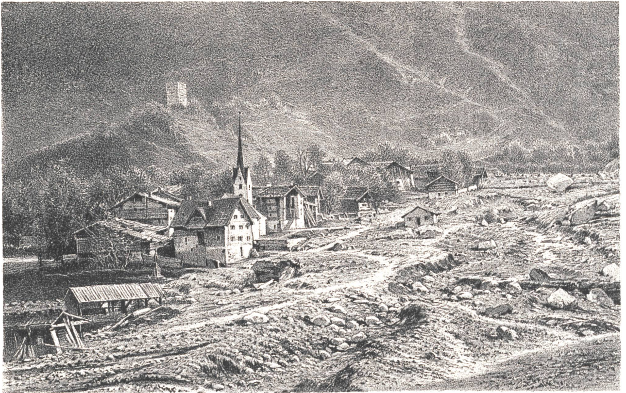
Bild 5. Die Folgen des Murganges von 1868 in Zignau (Stich von Coaz 1869 [4]). Die Kirche und das davor erkennbare Haus wurden von einem ähnlichen Murgang im Jahre 1927 zerstört und etwas weiter talab wieder aufgebaut. Die Bilder 6 bis 8 wurden vom fast gleichen Standort aus aufgenommen.
