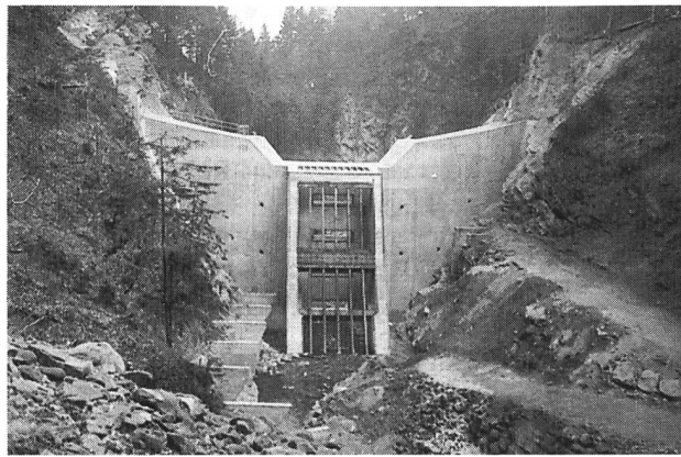
Bild 4. Die Palanggenbachsperre von oben. Im Rechenvorbau erkennt man die je fünf Rechenstäbe, die auf durchlaufenden Auflagerbalken liegen.
