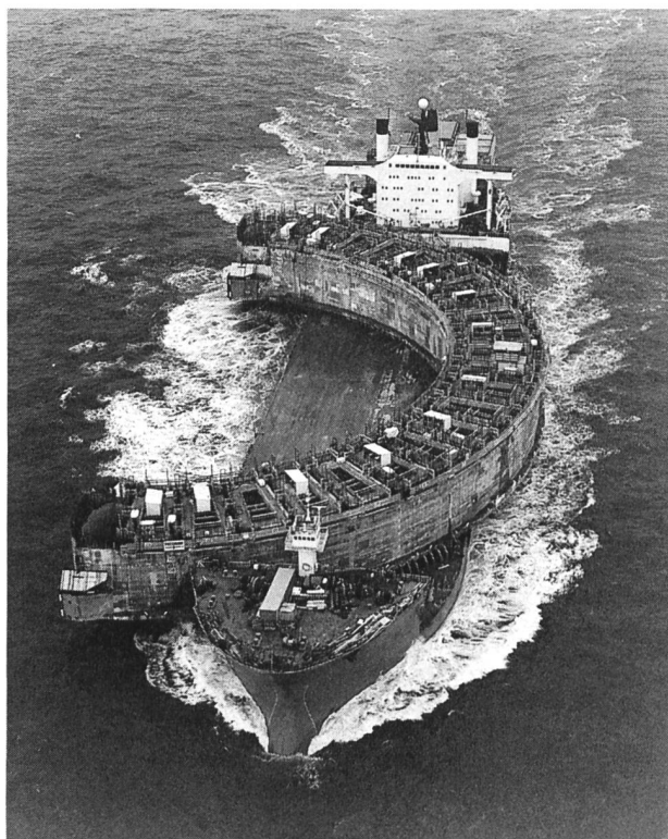
Bild 5. Transport eines der beiden Wandteilstücke mit einem Spezialschiff von Rotterdam nach Norwegen.
