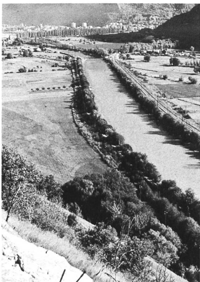
Bild 1, links. Die Rhone im Wallis wurde im letzten Jahrhundert praktisch auf der ganzen Strecke (vgl. Bild 2) korrigiert. Sie fliesst, gesäumt von Büschen und Bäumen, in einem Trapezprofil, dessen Ufer mit einem Blockwurf geschützt ist. Bild 2, rechts. Die der Rhone im Pfywald zugestandene Flussbreite erlaubt es ihr – im Gegensatz zu der korrigierten Strecke (vgl. Bild 1) –, in einem verzweigten Gerinne zu fließen.
