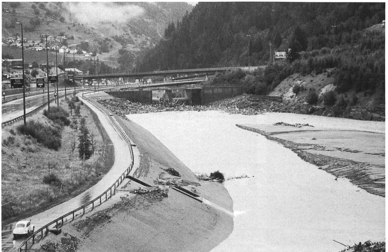
Bild 3. Becken des Falles 3 nach dem Hochwasserereignis.
