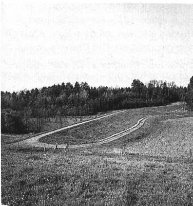
Bild 8. Hauptdamm luftseitig von Osten mit Kronen- und Dammfussweg, linke Bildhälfte Beckenfläche mit Ried und Wald.
