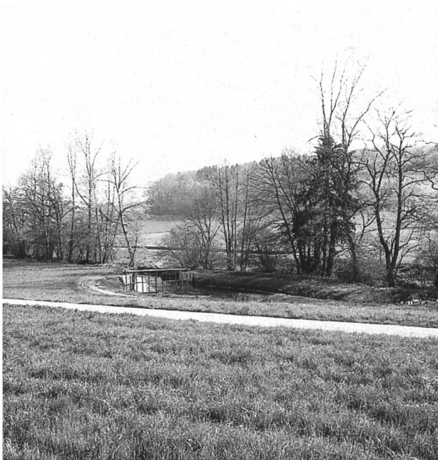
Bild 11. Geschiebeablagerungszone mit Rechen und Schwimmbalken in Bildmitte, links Kulturland des Stauraumes.
