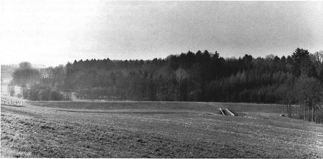
Bild 7. Hauptdamm luftseitig, in rechter Bildhälfte Auslaufbauwerk.
