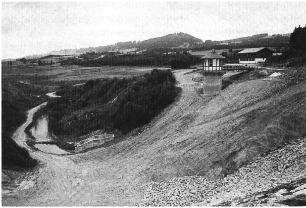
Bild 3. Rottachtalsperre: Schieberschacht; links unten Einlauf zum Grundablass (jetzt Baumleitung).
