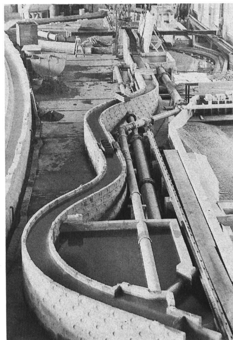
Bild 3, links. Sektion Erzeugung mit Exponaten der Schweizer Industrie: Turbinen, Generatoren, Druckleitungen und Abschlussorgane. Schiffliabach: Länge 1800 m, Fliessgeschwindigkeit 1,4 bis 1,6 m/s, maximale Förderkapazität 1080 Personen pro Stunde (Foto Ringier Dokumentationszentrum).
