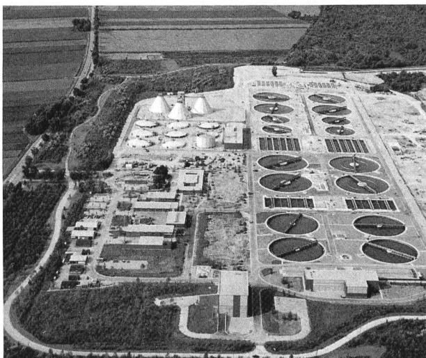
Bild 1. Das Klärwerk München II mit 32 rissfreien Betonbauwerken ohne Dehnungsfugen.
