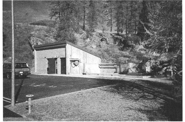
Bild 4. Gesamtansicht der Aufbereitungsanlage bei der ARA S-chanf.
