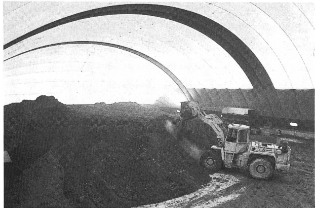
Bild 3. Zur Entgasung wird der entwässerte Klärschlamm in der Traglufthalle umgeschichtet.
