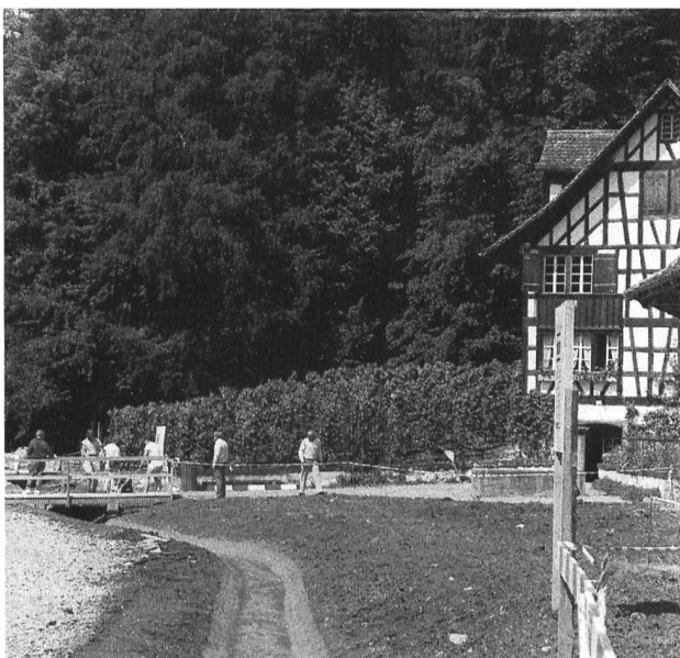
Bild 3. Beim Bau des Museumsbaches Ballenberg.
