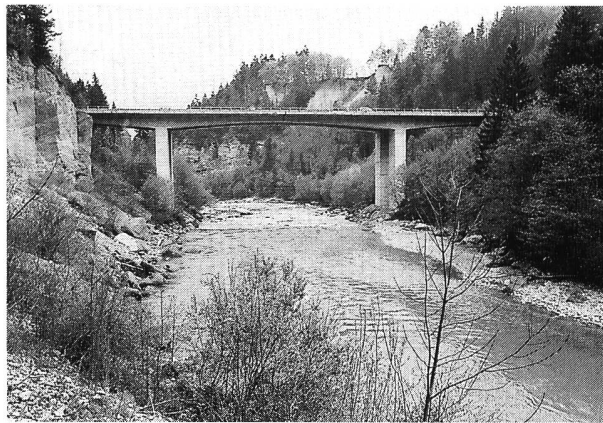
Bild 9. Kanderschlucht heute, in Fliessrichtung gesehen. Die einstige Kandersohle lag auf der Fahrbahnhöhe der heutigen Autobahnbrücke (N6).
