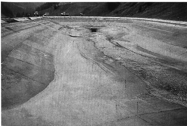
Bild 4. Das leere Ausgleichsbecken am 27. August 1981 um 9.45 Uhr. Das Spülwasser stammt aus dem Elektrizitätswerk der Landschaft Davos.
