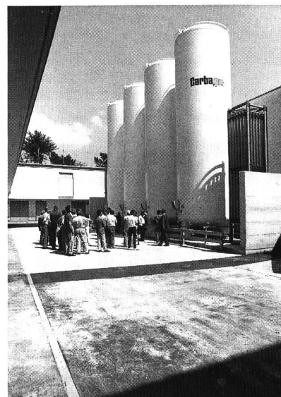
Bild 2. Lagertanks für flüssigen Sauerstoff.
