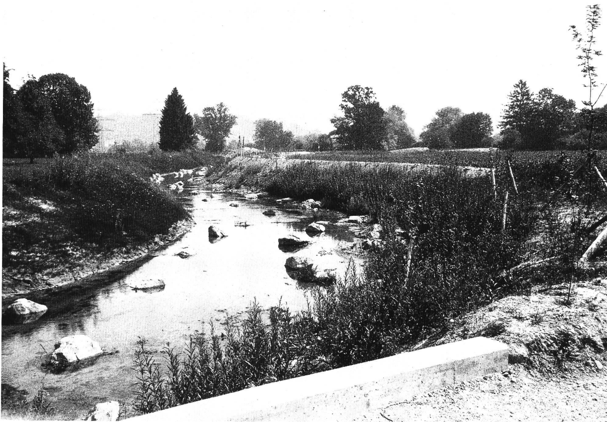
Bild 10. Die Aufnahme zeigt die gleiche Bachstrecke wie Bild 9 drei Monate später im Juni 1989. Die Weiden haben bereits ausgeschlagen. Die Ufer sind reich bestockt. Die Blöcke im Bachbett bilden eine Niederwasserrinne.
