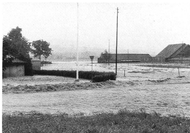
Bild 2. Immer häufiger tritt der Rotbach über die Ufer und überflutet Baugebiete und Kulturland. Das Bild zeigt die Überschwemmung im Raum Neuhörsen in Emmen während des Hochwassers vom 18. Juni 1989. Weite Gebiete stehen unter Wasser.
