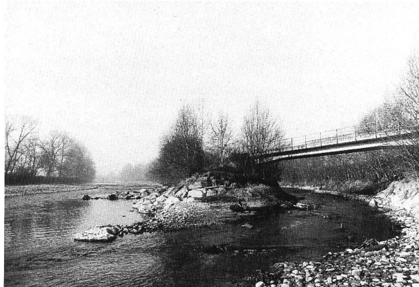
Bild 3. Früher mündete hier nur der Winkelbach in die Reuss. Zusammen mit dem Bau der Nationalstrasse wurde der Rotbach mit dem Winkelbach vereinigt und die Einmündung des Rotbaches um etwa 900 m flussabwärts verlegt.
