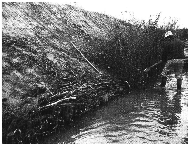
Bild 7. Ein Arbeiter verlegt die Spreitlagen. Die Faschinenwalzen sind bereits versetzt.
