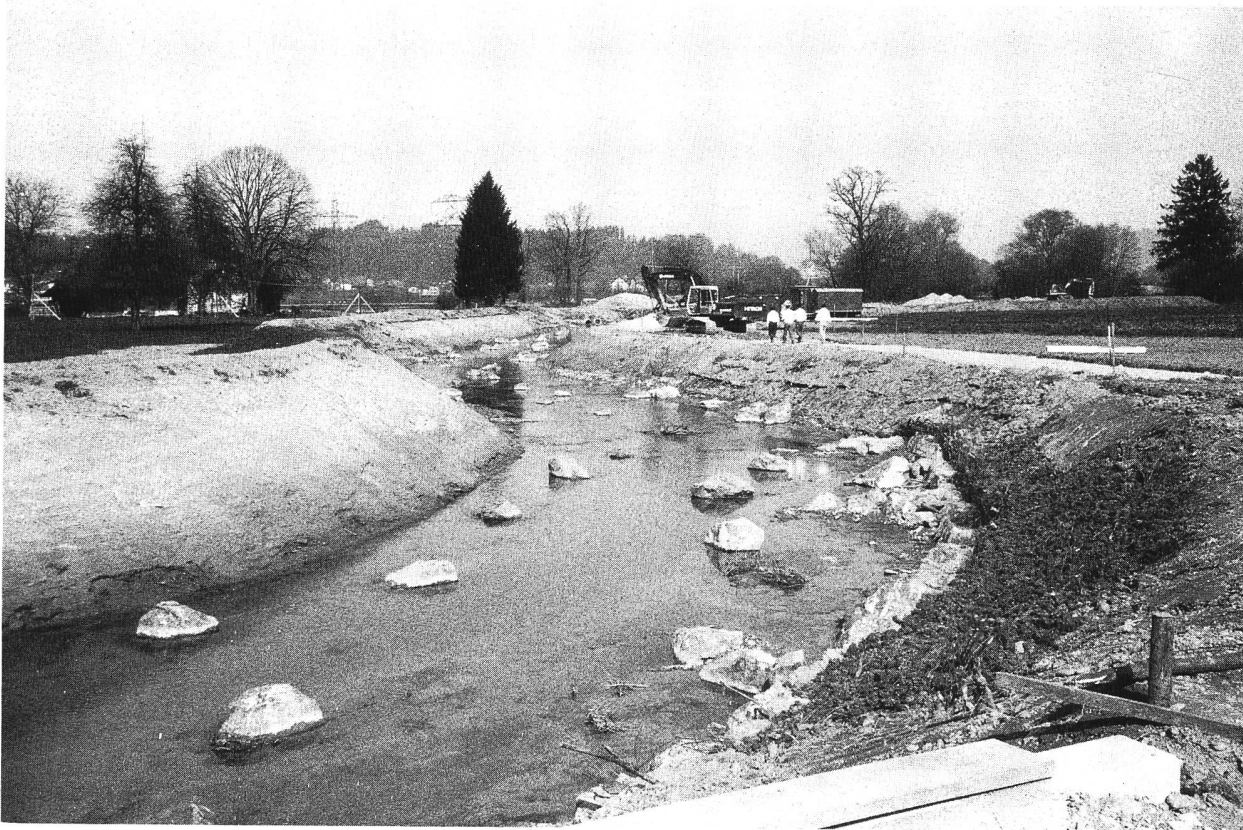
Bild 9. Das Foto zeigt eine Bachstrecke unterhalb der Sagenbacheinmündung während der Bauarbeiten im März 1989. Die Böschungen sind mit Blöcken und Lebendverbau gesichert. Für die Innenkurve genügt eine artenreiche Ansaat.
