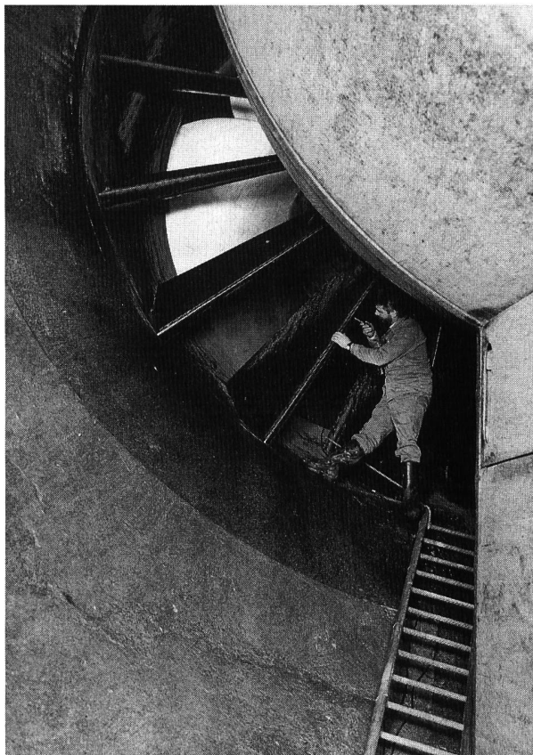
Revision im Aarekraftwerk Gösgen, erbaut 1914–17 (Foto Atel).
