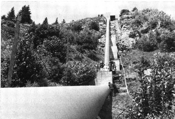
Figura 3. ...ed ecco come si presenta ora la condotta a lavori ultimati.
