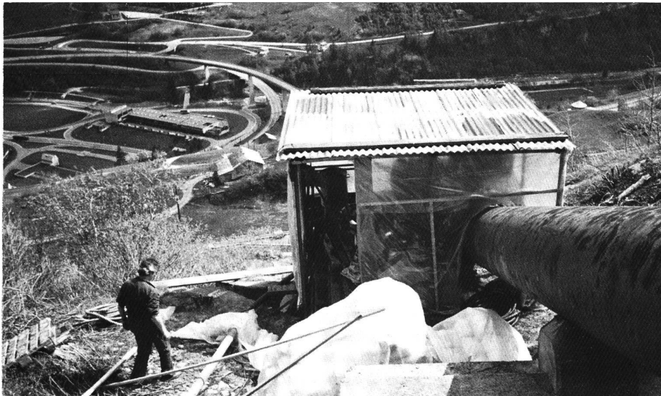
Figura 1. Stato della tubazione prima del trattamento e piattaforma di lavoro per il trattamento interno.
