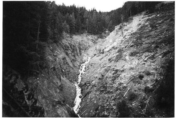
Bild 3, rechts. Ausgeräumter Bachabschnitt mit nachrutschenden Bach-einhängen nach zwei Unwettern 1987. Die Tiefenerosion beträgt an dieser Stelle ungefähr 8 m, die Erosionsleistung 300 \text{ m}^3/\text{m} .
