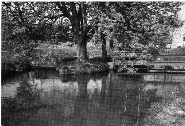
Bild 3. Die Wasserfassung für das Kraftwerk Innere Spinnerei in Unterägeri hat die Aufgabe, den Ägerisee soweit als möglich zu regulieren. Wehr und Einlauf aus dem Jahre 1922, revidiert 1988, sind aus dem heutigen Landschaftsbild kaum mehr wegzudenken.
