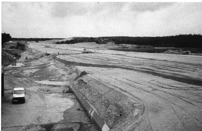
Bild 3. Im Bau befindliche Rothsee-Hauptsperre.
