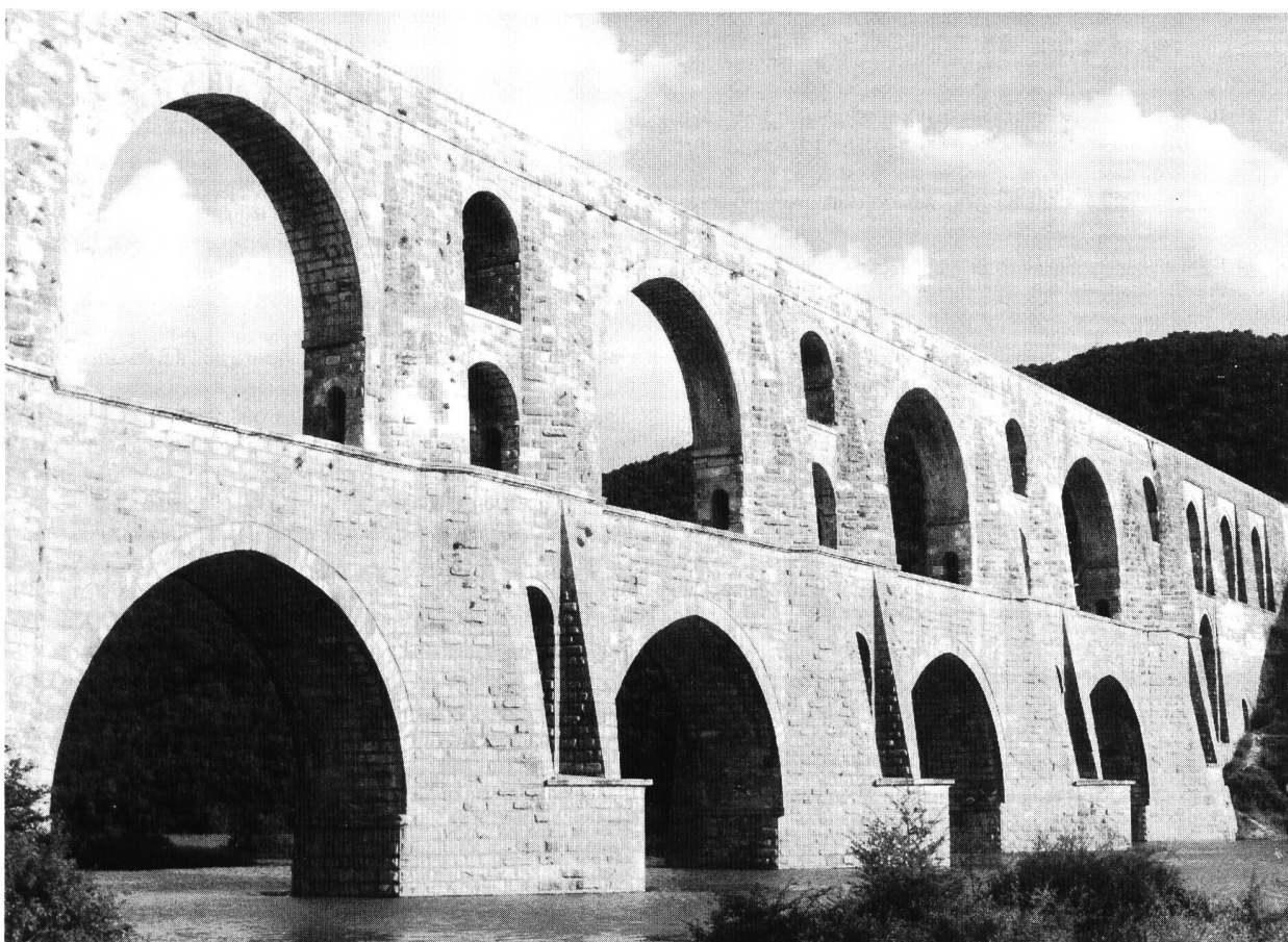
Bild 3: Der Maglova-Aquädukt an der Kirkçeşme-Leitung nach Istanbul (Foto des Autors).
