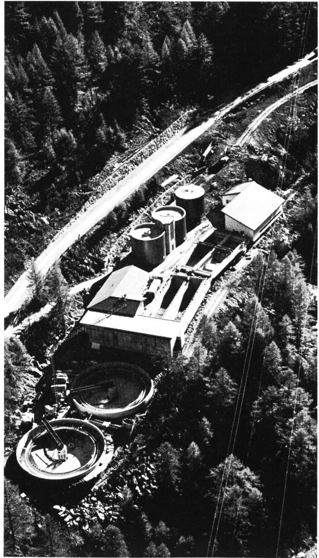
Bild 1. Übersicht über die Abwasserreinigungsanlage Saastal. Von vorne nach hinten: Nachklärbecken, Schlammdeponie, Betriebsgebäude, Belüftungsbecken, Vorklärbecken, Nachfaulraum, Faulraum, Gasometer-Eindicker, belüfteter Sandfang, Rechengebäude.
