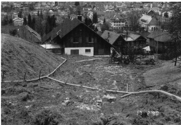
Bild 5. Auslaufzone der Rutschung «Hofstatt». (Fotos: P. Steiner)
