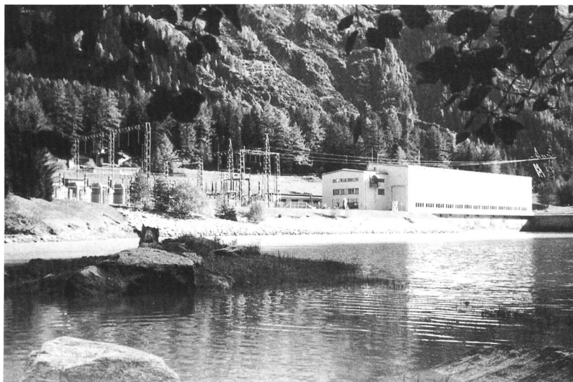
Bild 2, rechts. Das Kraftwerk Löbbia mit der 225-kV-Schaltanlage und dem Ausgleichsbecken.
