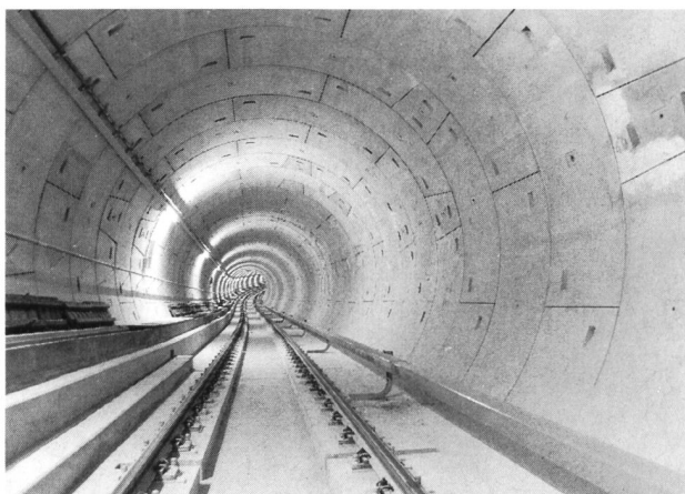
Bild 1. Tunnelauskleidung mit Stahlbetontübbing – Baulos Wöhrder Wiese, U-Bahn Nürnberg.
