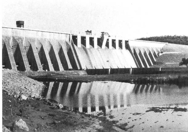
Bild 1. Gewichtsmauer mit Pfeilerköpfen als Hauptteil der 1,6 km langen Talsperre Manantali in Mali.
