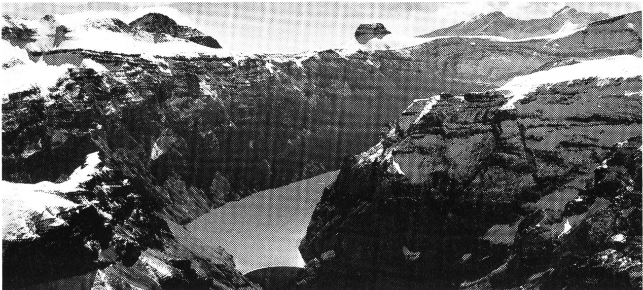
Stausee Limmernboden des Pumpspeicherwerks Tierfehd (Kanton Glarus).
