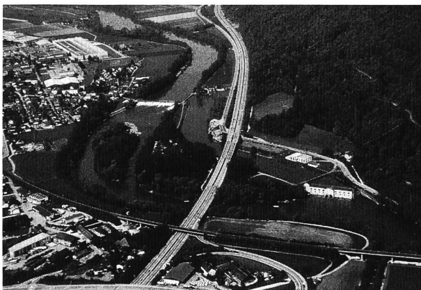
Bild 1. Das Kraftwerk Ruppoldingen, eines der ersten grösseren Kraftwerke der Schweiz. Links oben das Stauwehr, anschliessend rechts der Kanal, wie er damals bei Kraftwerken üblich war. Im alten Aarelauf unterhalb des Stauwehrs liegen die Ruppoldingener Inseln.
