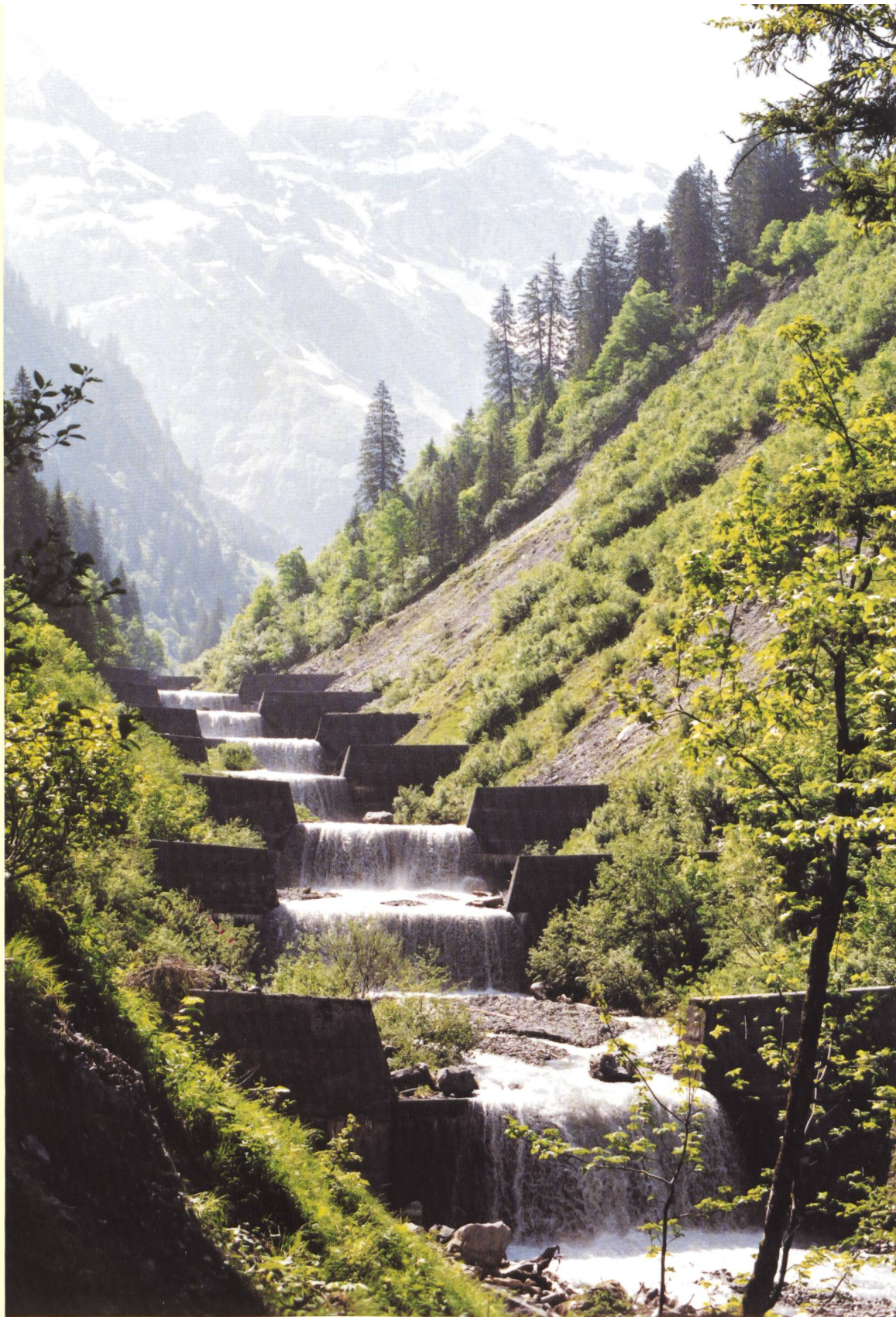
Dank massiven Wildbachverbauungen im Durnagelbach konnten im August 1991 grössere Schäden, wie anno 1944, vermieden werden. Foto O. Gebhardt, Zürich. Siehe auch Gerhard Röthlisberger: Unwetterschäden in der Schweiz 1991 , S. 37 bis 41.
