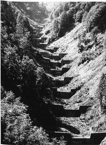
Bild 2. Dank massiven Wildbachverbauungen im Durnagelbach konnten am 11. August 1991 grössere Schäden, wie anno 1944, vermieden werden. Foto: J. Zeller, 1972, WSL
