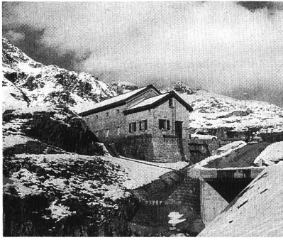
Bild 5. Das Maschinenhaus Sella.
