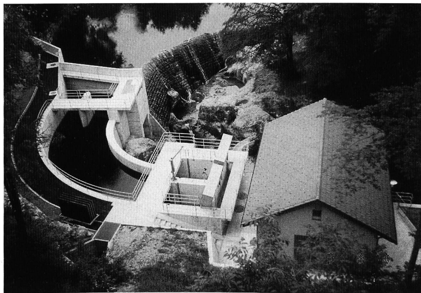
Bild 5. Stauwehr im Bauzustand. Erstellung der Natursteinverkleidung und Mauerbresche in Wehrmitte für Baumleitung.
