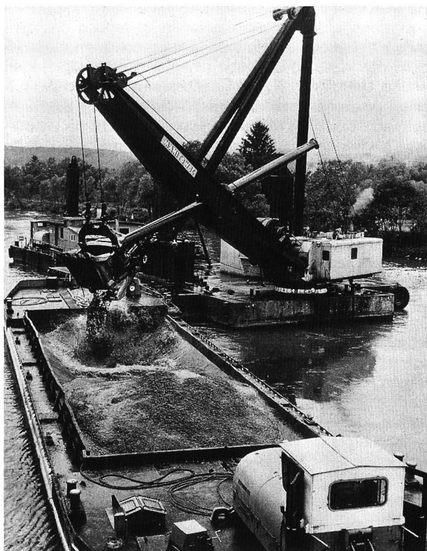
Figure 1. La drague Manitowoc avec bateau à clapets automateur 500 t utilisée lors des travaux de la 2 e correction des eaux du Jura. (photo WEA, canton de Berne)
