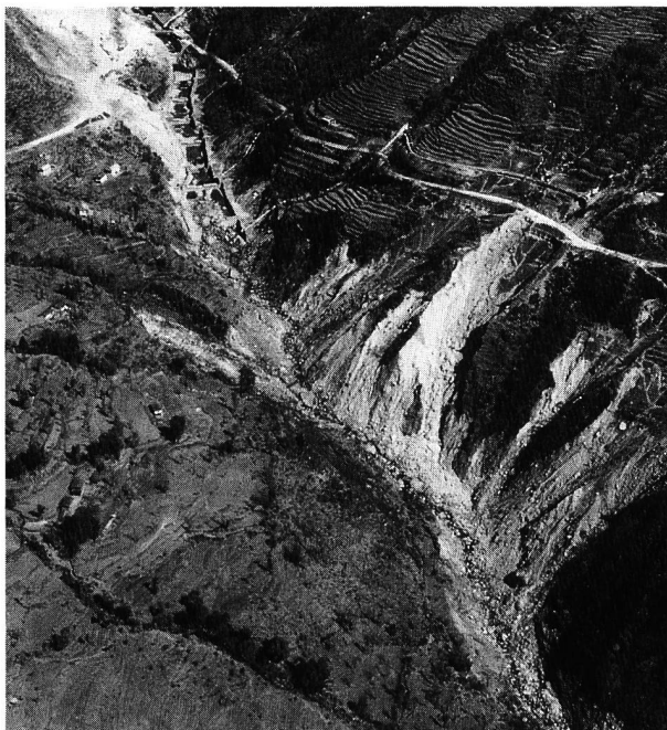
Bild 1. Situation am Charnawati im Frühling 1990. Unterhalb der Strassenquerung (am linken oberen Bildrand) ist der Fluss mit Steinkorb-sperren verbaumt. Im anschliessenden Steilbereich erreichen die ausgedehnten Hangrutschs die Strasse.
