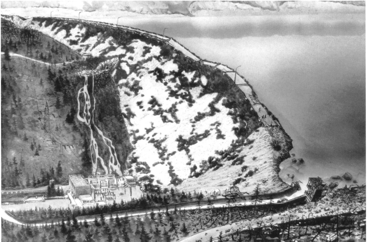
Bild 3. Gemälde der Luftseite mit den Schadstellen: rechts Krater der Sprengladungen 1 bis 3; in Kronenmitte Setzung infolge Sprengung 4; links oben Krater der Sprengladung 5; darunter schlammhaltige Wasseraustritte aus einem der Zugänge zum Sohlgang (aus: Int. Workshop on Dam Safety Evaluation, suppl. vol.).
