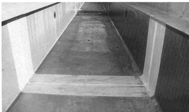
Bild 4. Mit dem Sikadur-Combiflex-System abgedichtete Wand- und Bodenugen einer Auffangwanne.
