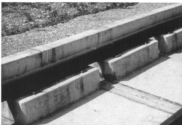
Bild 6. Das Sikadur-Combiflex-System zur Abdichtung von Bodenugen in einem Umschlagplatz (Bahn).
