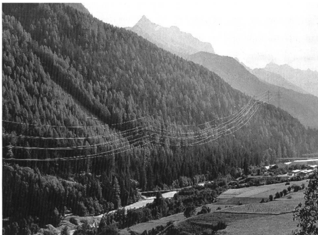
Bild 5. Eine 400-kV-Doppelleitung hat eine Übertragungskapazität von 1200 MW (Foto: Feuerstein, Scuol).
