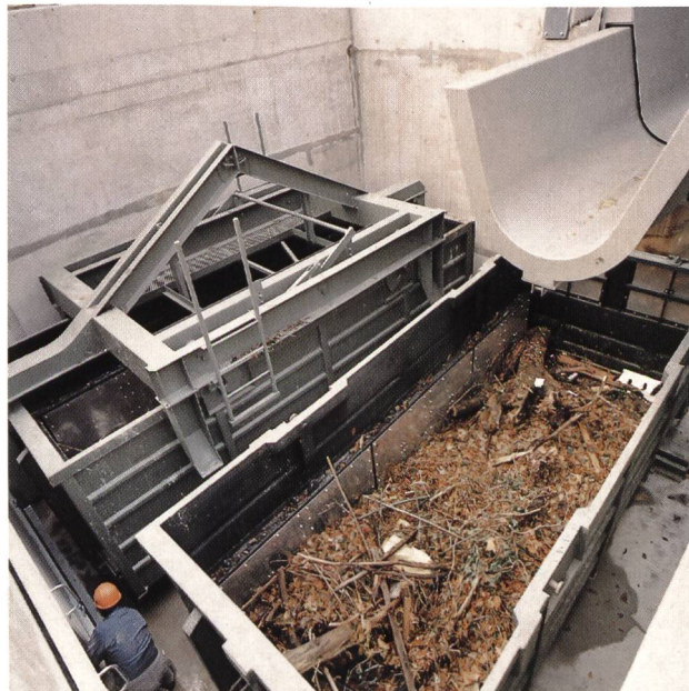
Bild 33, oben. Einläufe der Turbinen S1, S2 und S3. Links im Bild steht die Rechenreinigungsmaschine. Die Geschwemmselrinne führt zu den versenkten Containern, die das Rechengut aufnehmen.
