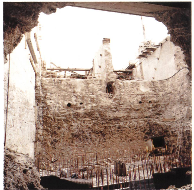
Bild 3. Blick in die Baugrube für die Straflo-Gruppe 1.
