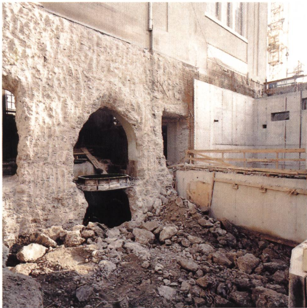
Bild 5. Alte Bausubstanz aus den Jahren 1908 bis 1912. Der Beton ist nahezu ohne Bewehrung.
