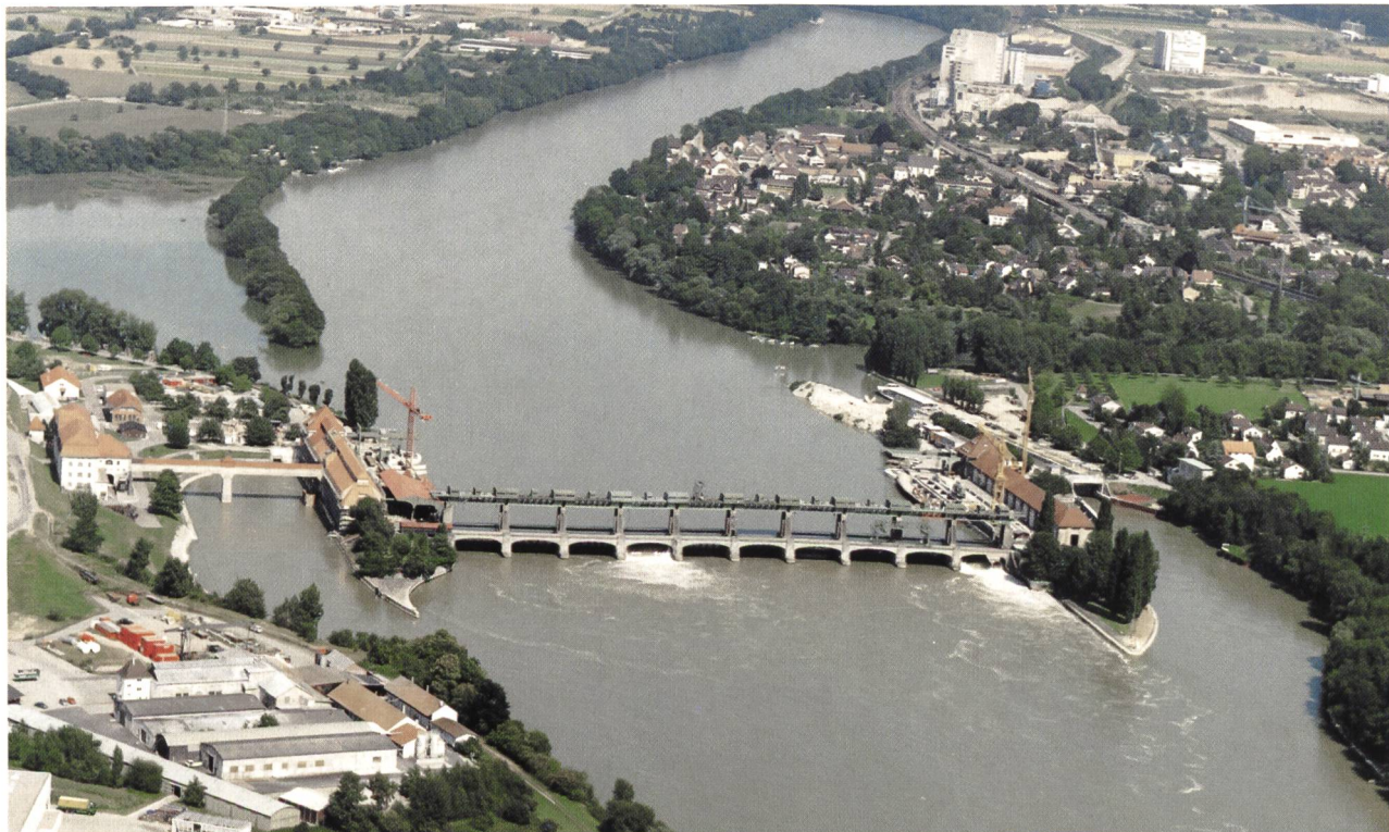
Bild 1. Gesamtansicht rheinaufwärts der Kraftwerke Wyhlen (links im Bild) und Augst.
