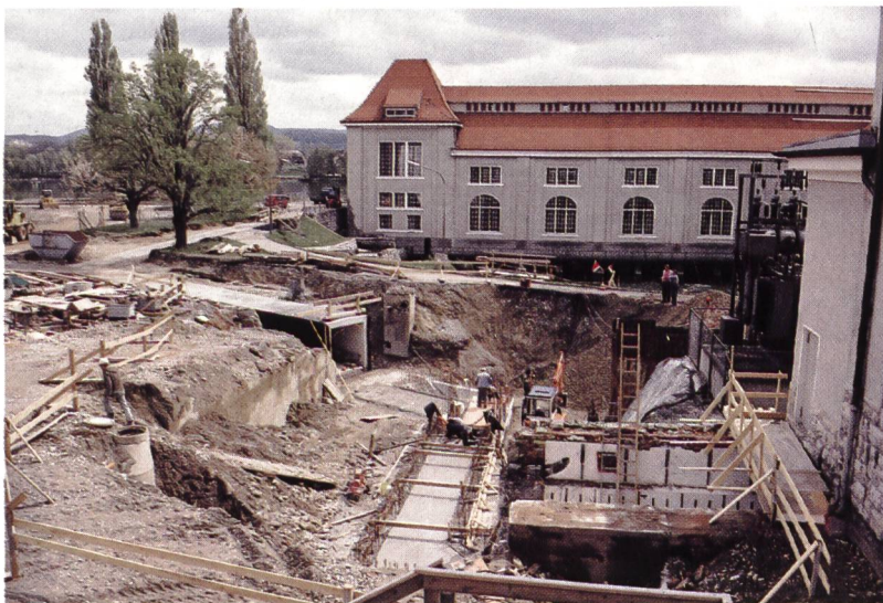
Bild 23. Anbindung des Energieableitungskanals ans Umspannwerk.
