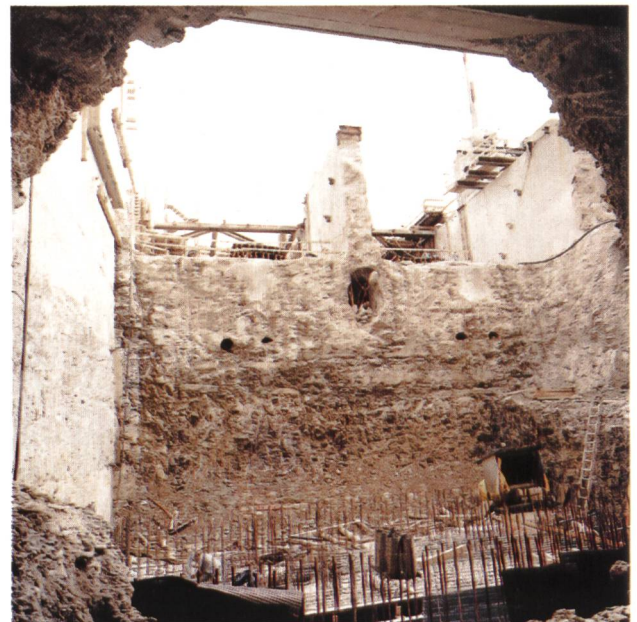
Bild 3. Blick in die Baugrube für die Straflo-Gruppe 1.
