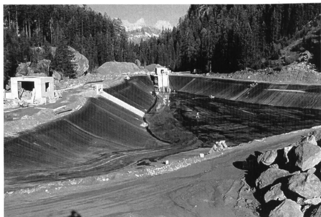
Bild 1. Ausgleichsbecken Merlen nach dem Einbau der Asphalt-dichtung.
