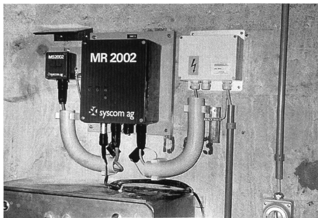
Figure 6. Vue d'ensemble de l'installation d'une station.
