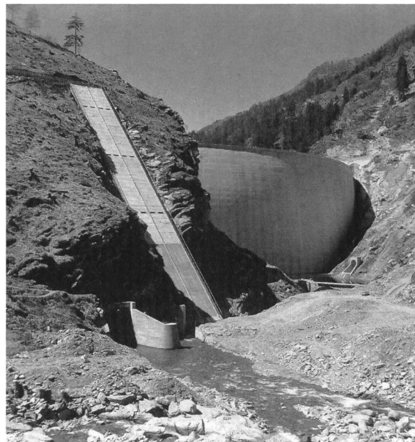
Bild 1. Stauanlage am Ende der Bauarbeiten im Jahre 1959.
