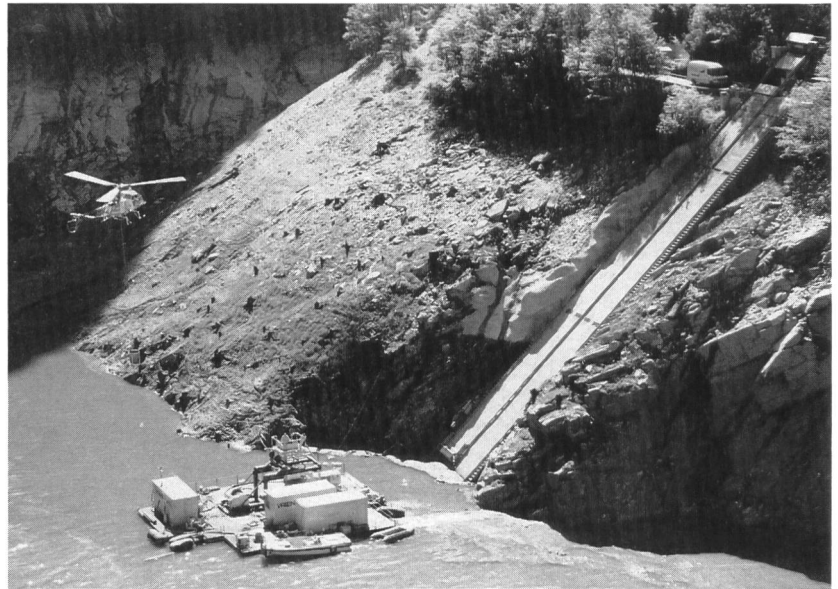
Bild 7. Transport und Einbringen des Unterwasserbetons.
