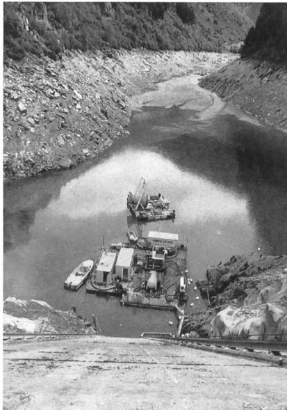
Bild 6. Pontoneinrichtungen für die Unterwasserarbeiten und das Absenken des Einlauftrichters.
