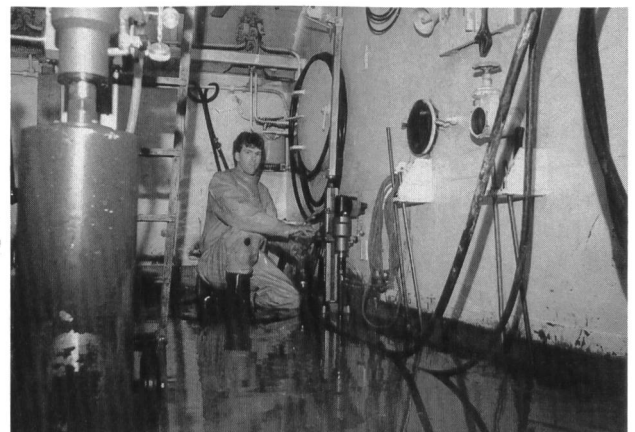
Bild 8. Bohr- und Ausbrucharbeiten in der Druckkabine bei etwa 20 m Wasserdruck.
