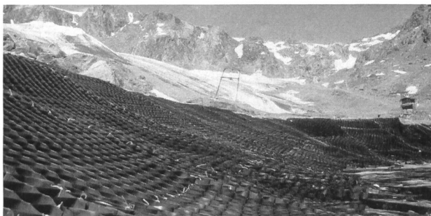
Bild 3. Sicherung der Dammböschung des Speichersees mit Geozellen aus Kunststoff.
