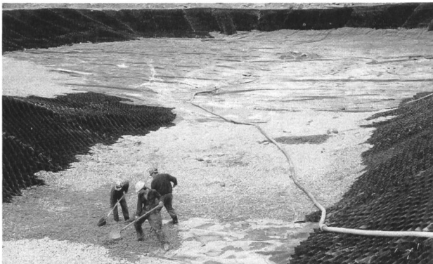
Bild 2. Einbau einer Kiesschicht zum Schutz der Kunststoffdichtungsbahn auf der Sohle des Speichersees.
