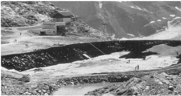
Bild 1. Wasserspeicher am Fuss des Pitztalgletschers – während des Baus.
