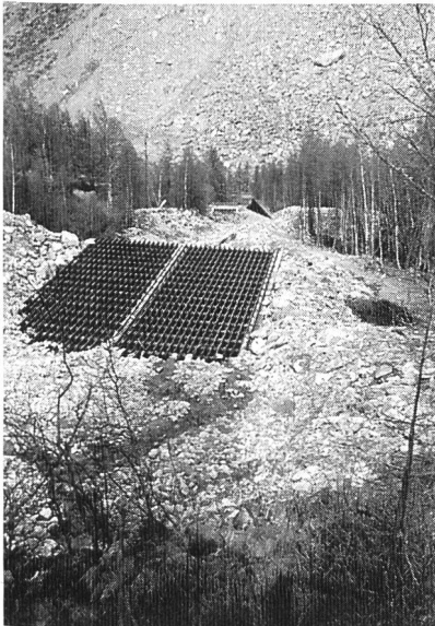
Bild 6, links: Murgangsbremse (horizontaler Rost): Länge 19 m, Breite 12 m. Bachabwärts ist der Rückhaltedamm zu erkennen (Pfeil). Photo vom 30. April 1993
