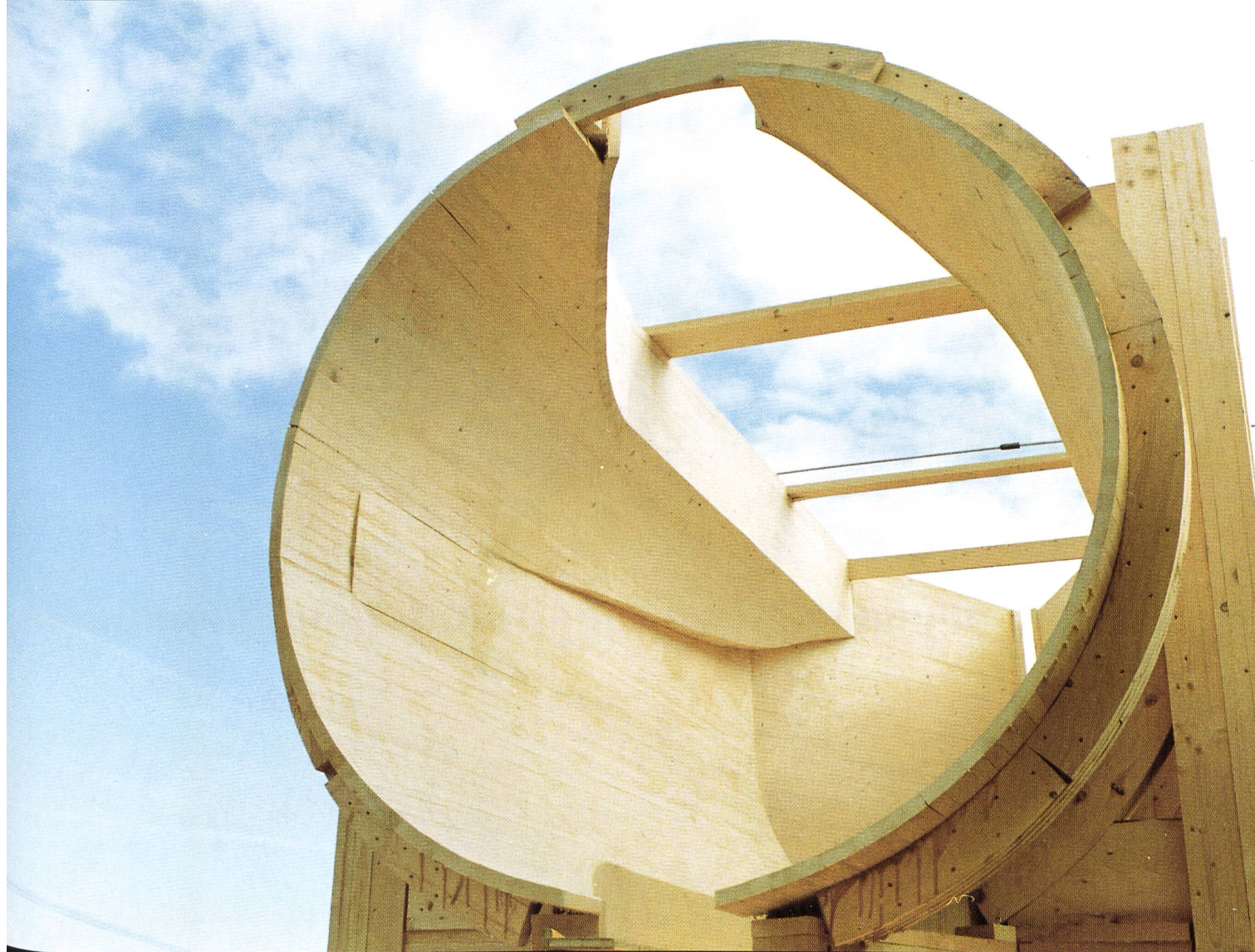
Vorfabrizierte Schalung für den Turbinen-Einlaufbereich beim Kraftwerk Augst. Die gleiche Schalung wurde für alle sieben neuen Einheiten verwendet.
